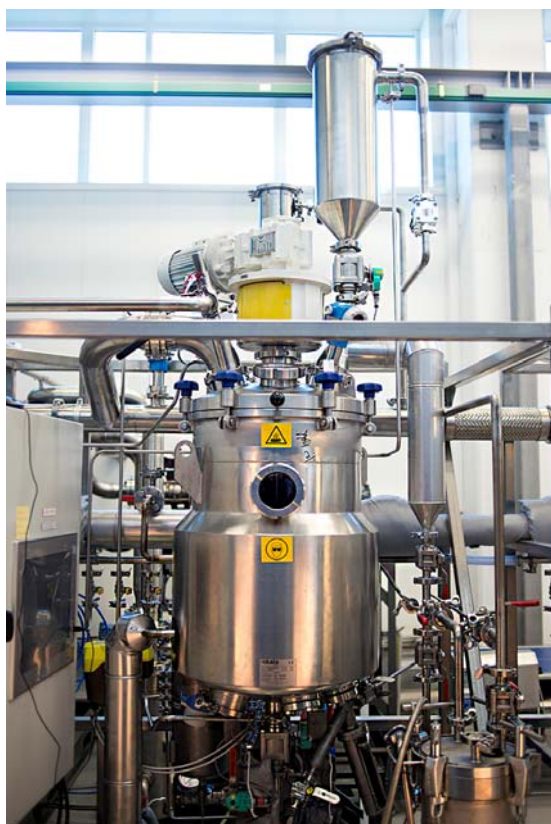
Foto: SINTEFs raffineringsanlegg for marine oljer
