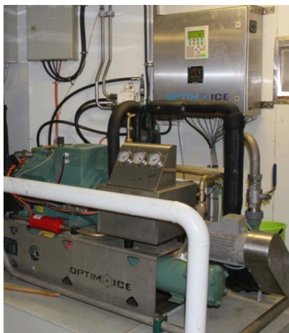
Figur 2.3 Isslurryanlegget om bord i M/S Loran til venstre, isslurry i ublødningstank til høyre.
