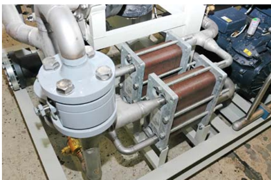
Figur 6 Bilde av sugegassvarmeveksler
