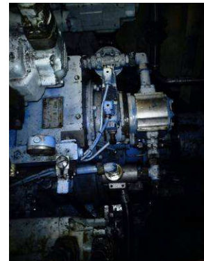
Bilde 4: hydraulikkanlegg påmontert gir hos deltaker
