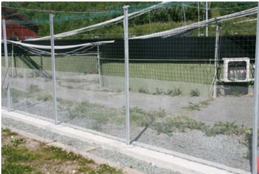
Figur 8. Områdesikring for sekundærsikring ved karbrudd og slangebrudd
