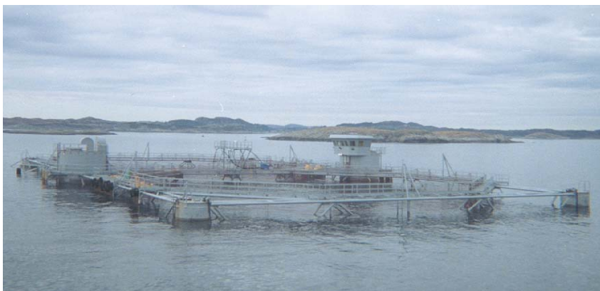
Figur 2.5. Fagverks stålanlegg, Storm.
