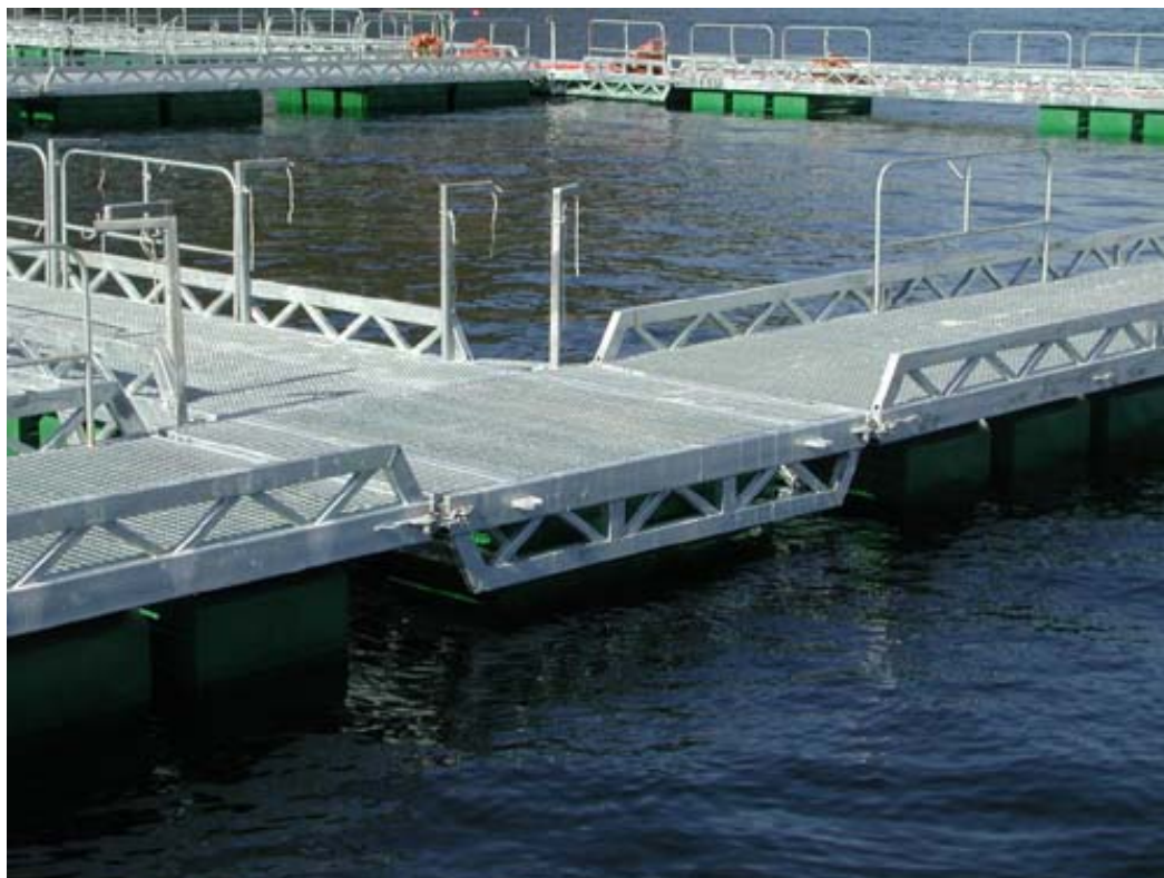
Figur B.1. NM 5000 anlegg med fagverkforsterkning.
