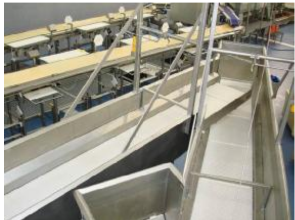
Figur 5. Overgang mellom første og andre transportbånd i filetkjøler sett fra utmatingsenden.
