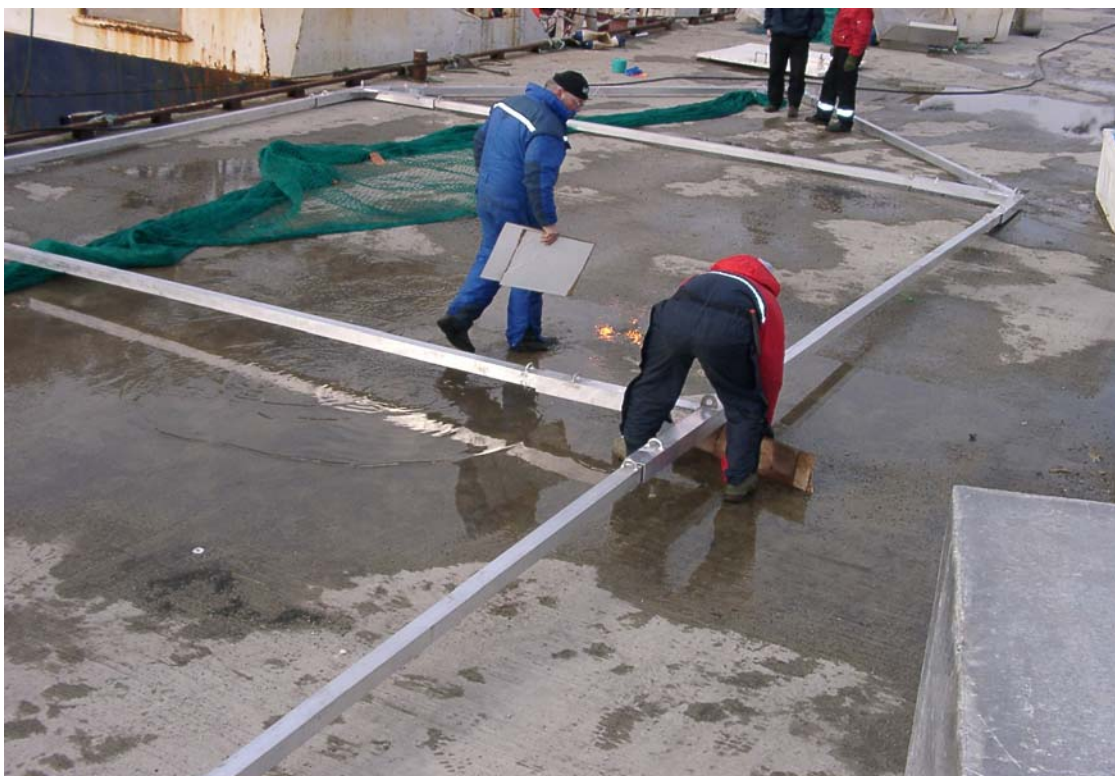
Bilde 4. Rammeverk av aluminium settes sammen ved hjelp av skjøtestykker.
