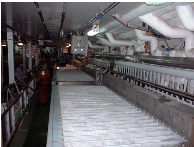
Bilde 12: Bedre plass på fabrikkdekk etter forlengelse på 6 meter
